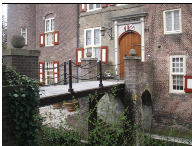
Houtenbrug in 2016 (Foto auteur)
