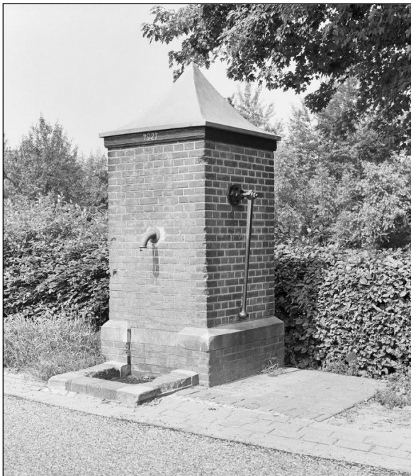
Waterpomp in 1980 (Foto Rijksdienst voor het Cultureel Erfgoed)
